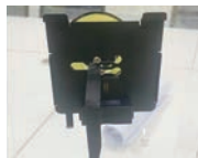
3. En el interior de la puerta, coloque el enchufe del cable y el tornillo pasará por la placa de montaje. [Nota- hágalo con cuidado, para romper el cable].
